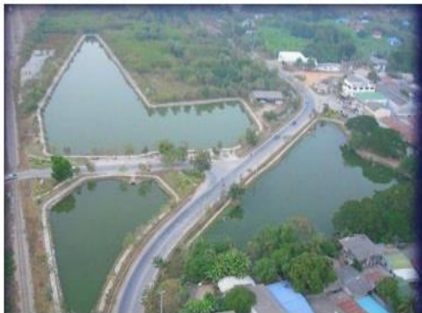
"โครงการแก้มลิง" หลักการของโครงการคือเมื่อเกิดน้ำท่วมก็ขุดคลองชักน้ำให้ไหลมารวมกันเก็บไว้ในแหล่งพักน้ำแล้วจึงค่อยทำการระบายลงสู่ทะเลผ่านทางประตูระบายน้ำในช่วงที่ ปริมาณน้ำทะเลลดลง ขณะเดียวกันก็สามารถสูบน้ำออกจากคลองที่เป็นแก้มลิงลงสู่ทะเลตลอดเวลาเพื่อที่น้ำจากตอนบนจะได้ไหลลงมาได้เรื่อยๆและเมื่อใดก็ตามที่ ระดับน้ำทะเลขึ้นสูงกว่าระดับน้ำในคลองที่เป็นแก้มลิงก็ให้ปิดประตูระบายน้ำกั้นไม่ให้ น้ำทะเลไหลย้อนกลับเข้ามา
